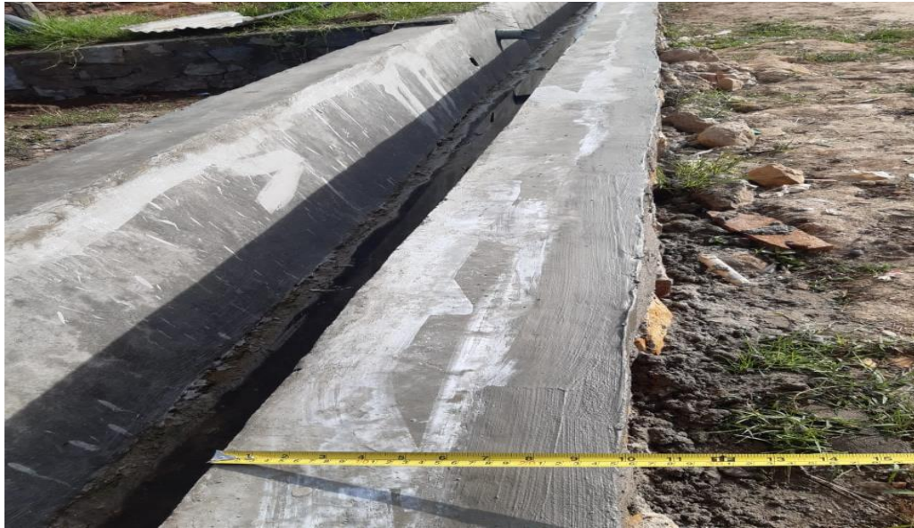
Gambar 3. Pembangunan Drainase Koto Laweh ke Padang Ambacang Nagari Situjuh Banda Dalam
