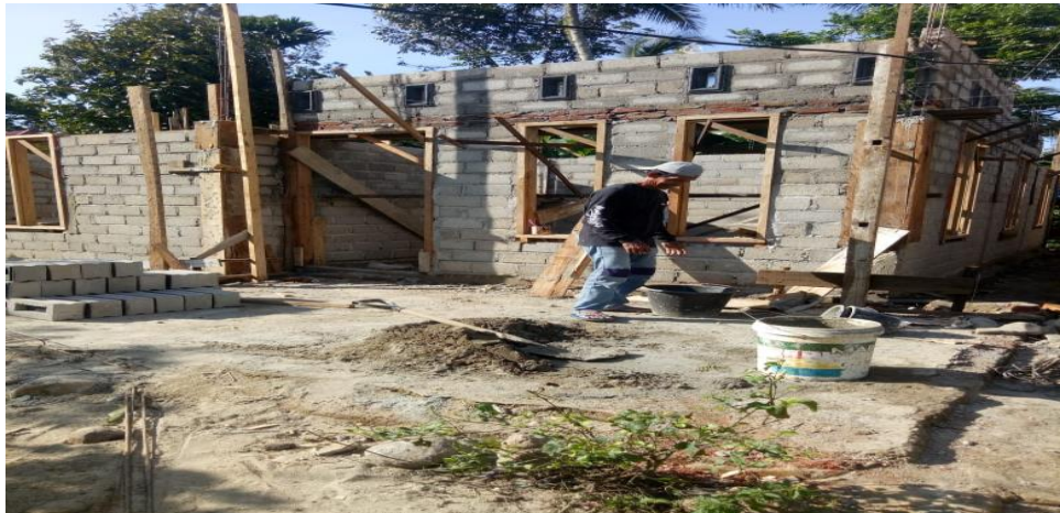
Gambar 2. Pembangunan Rumah Layak Huni Kondisi 50 %
