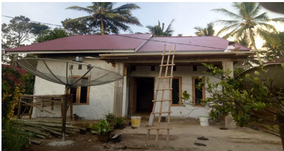
Gambar 3. Pembangunan Rumah Layak Huni Kondisi 100 %
