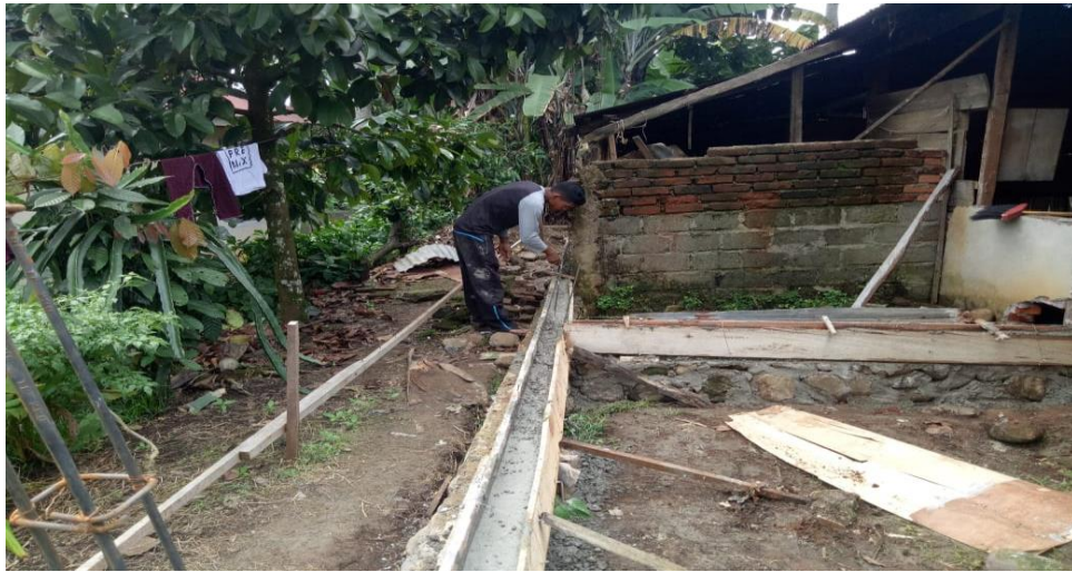
Gambar 1. Pembangunan Rumah Layak Huni Kondisi 0 %
